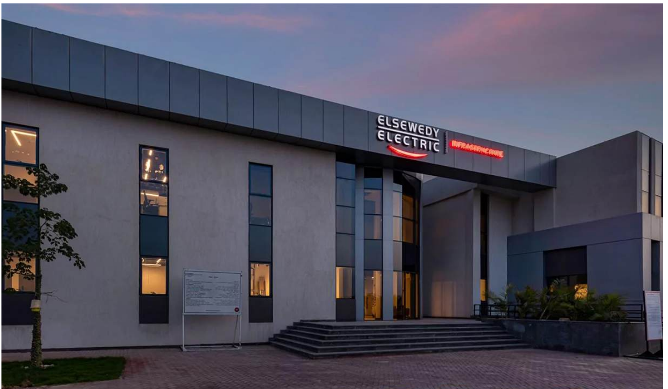
Project Name : El Sewedy Factory City : Egypt Date : 2021
