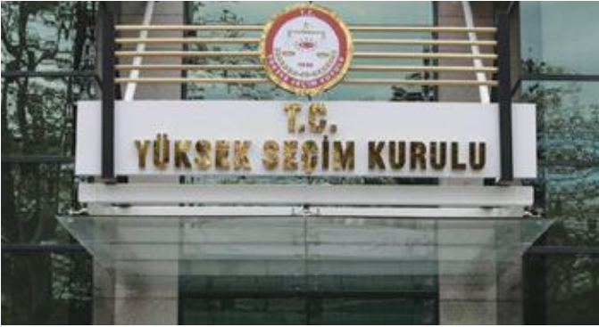
Ankara YSK Genel Merkez Binası
