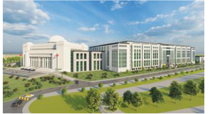
Ankara Yargıtay Hizmet Binası
